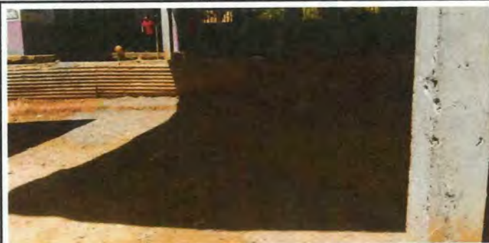
MODULO V: Se observa que la losa del patio es de tierra y se necesita una losa de concreto.
